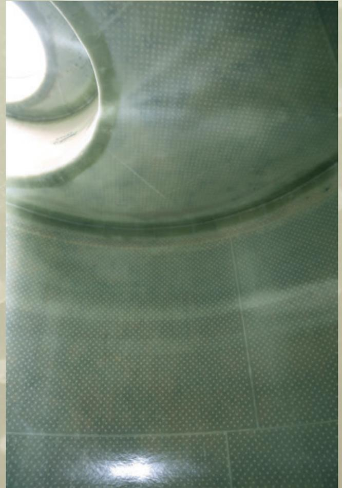
**Die vorgefertigten Noppenlamine aus Glasfaser und Polyesterharz werden aufgerollt wie ein Teppich angeliefert, durch den Schacht eingebracht und an allen Stößen und Verbindungsstellen dauerhaft dicht überlaminiert.**
